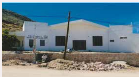
Stato dei lavori all'inizio di aprile 2015
