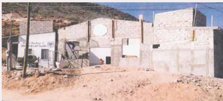
Avanzamento dei lavori a fine 2013
