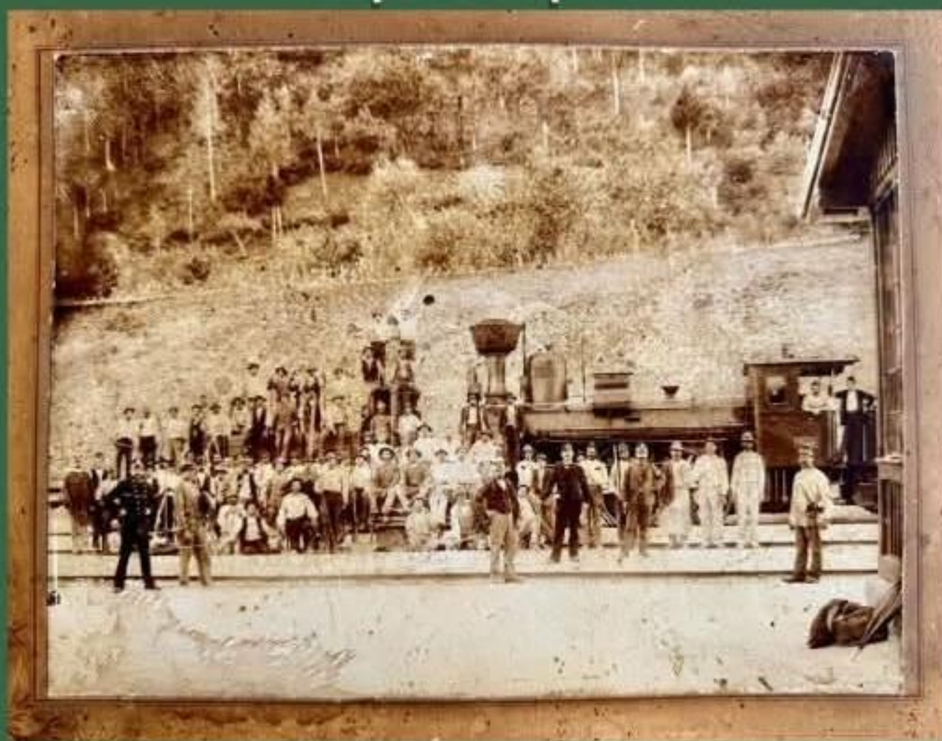
Roncagno. Stazione di Roncagno, ultimi lavori. Locomotiva KkStB 48, 1896, Archivio A.S.P.
