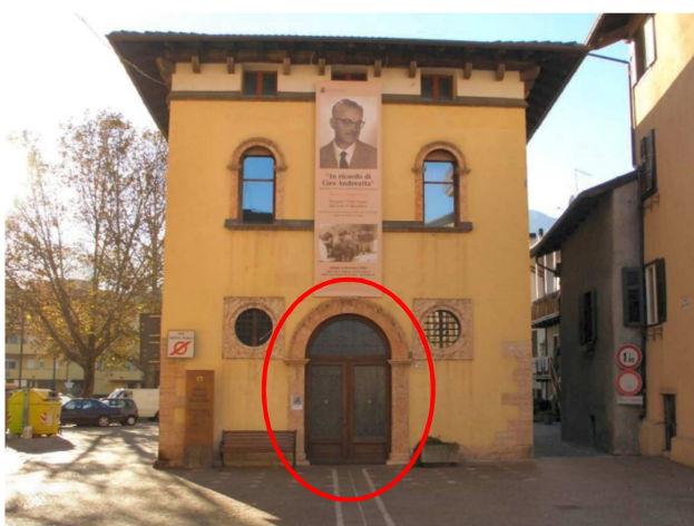
Esterno edificio con ingresso sala
