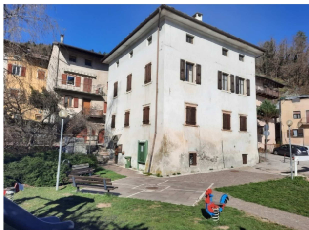
Edificio Casa Sociale – Ingresso sul retro edificio
