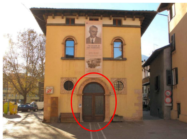
Esterno edificio con ingresso sala
