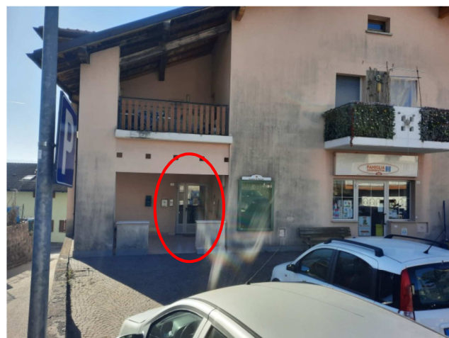
Lato anteriore edificio con Ingresso Sala
