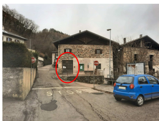
Edificio Casa Sociale con Ingresso Sala
