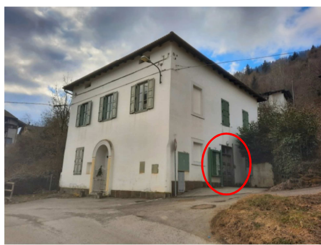
Edificio Casa Sociale con ingresso sala
