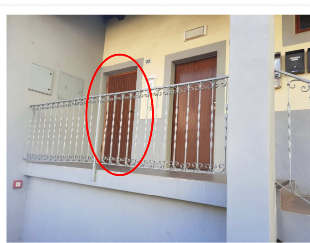
Ingresso Sala (retro edificio)
