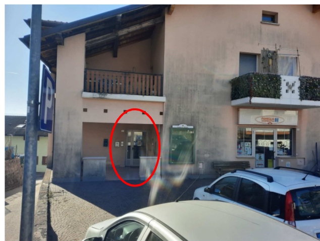
Lato anteriore edificio con Ingresso Sala
