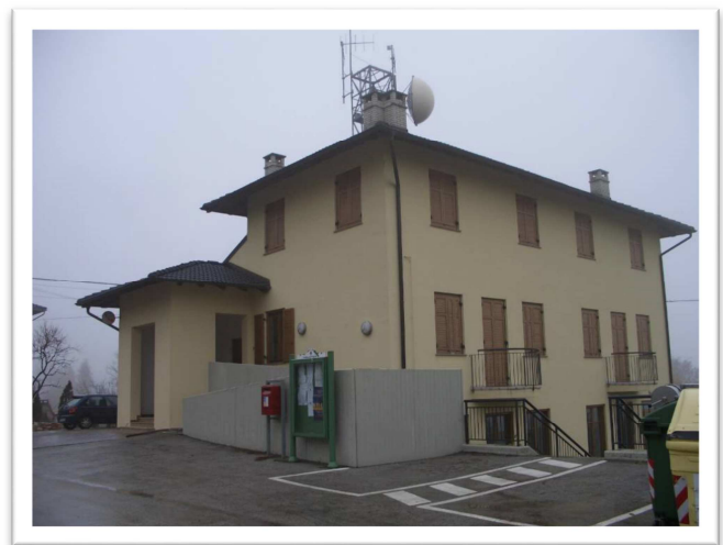
Esterno Edificio, lato strada
