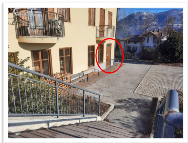
Accesso Sala, lato sud dell'edificio
