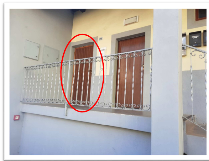
Ingresso Sala (retro edificio)
