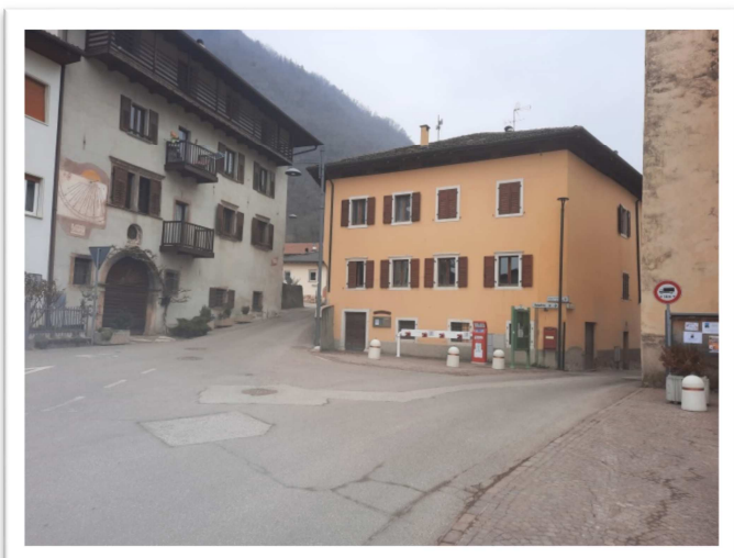
Edificio Casa Sociale – visuale da Piazza dei Santi Fabiano e Sebastiano
