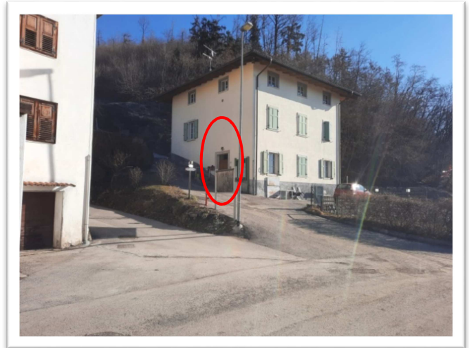
Edificio Casa Sociale con accesso atrio antistante la sala
