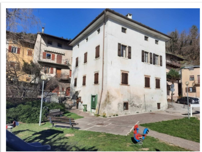
Edificio Casa Sociale – Ingresso sul retro edificio
