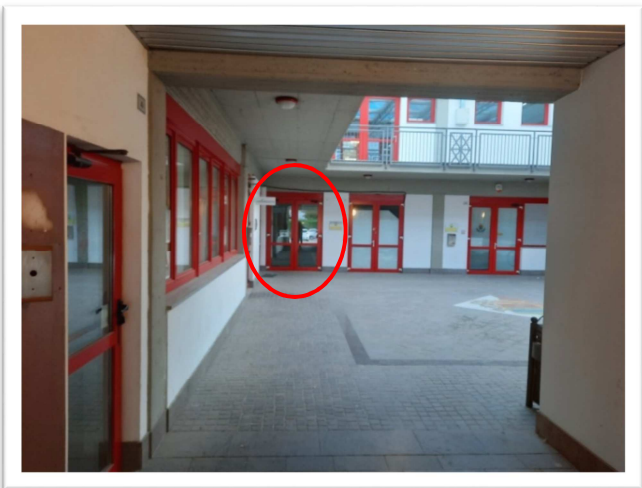
Porta accesso vano scale che conduce alla sala sita al primo piano
